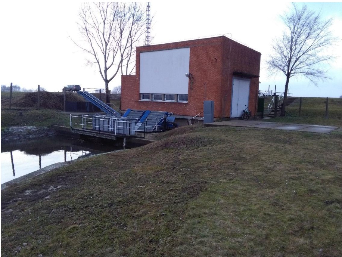
3. kép Alsófuttaki szivattyútelep napjainkban
