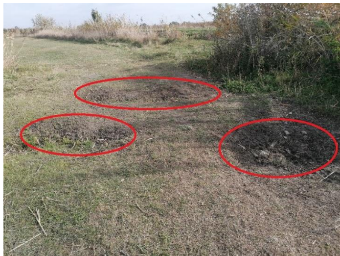
3. fénykép: A torkolati műtárgy 2. fénykép: Mély horpadások a műtárgy keretelemei felett
