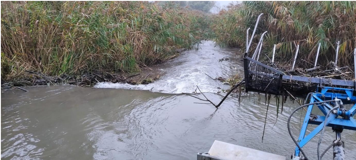
14. kép Hód által épített duzzasztógát
