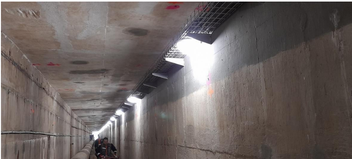
Elektromos rekonstrukció – új vezetékek és világítás a közlekedőalagútban
