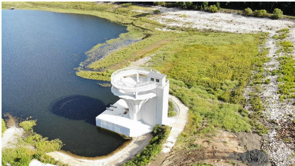
Az egyesített műtárgy a rekonstrukció után
