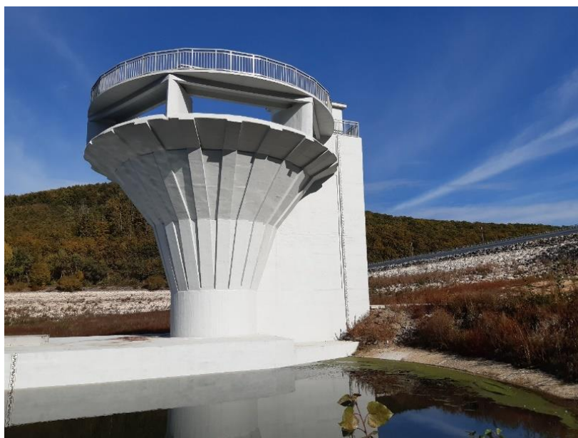
Az egyesített műtárgy a rekonstrukció után
