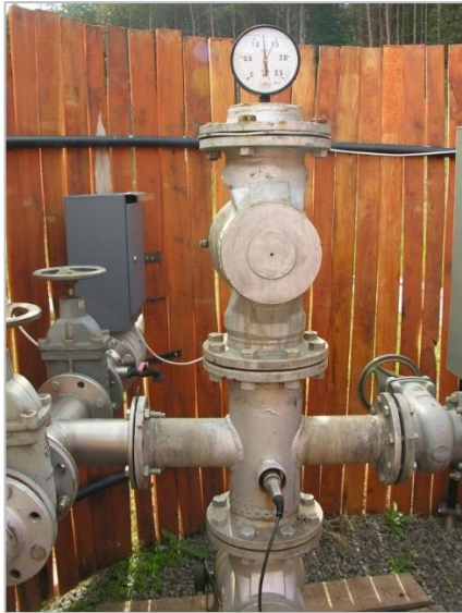
2c,d. ábra. Becsavarozott DATAQUA mérőeszközök termálkarsztkutak kútfejein (Fotó Lénárt László)
