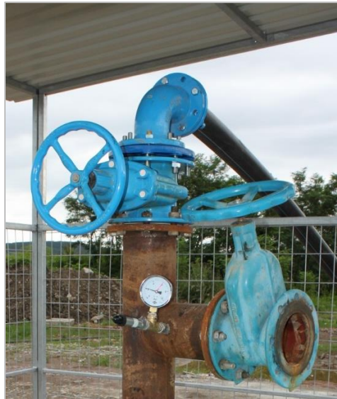
2c,d. ábra. Becsavarozott DATAQUA mérőeszközök termálkarsztkutak kútfejein (Fotó Lénárt László)
