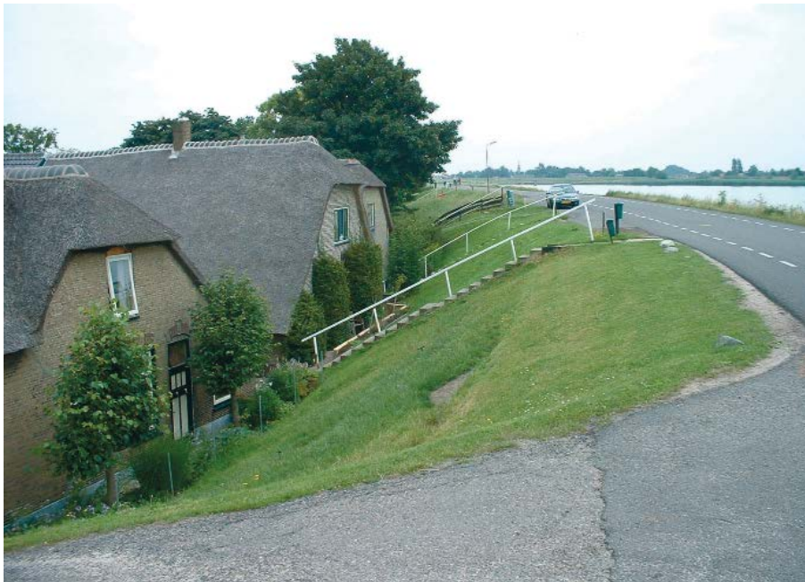
8. kép Több ezer házra a gát ráépült a mentett oldali erősítések következtében
