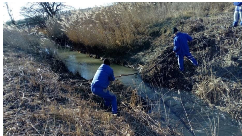
Hódgátak elbontása kézi erővel (Sárvár, Szaput-árok és Peresznye, Boldogasszony-patak)
