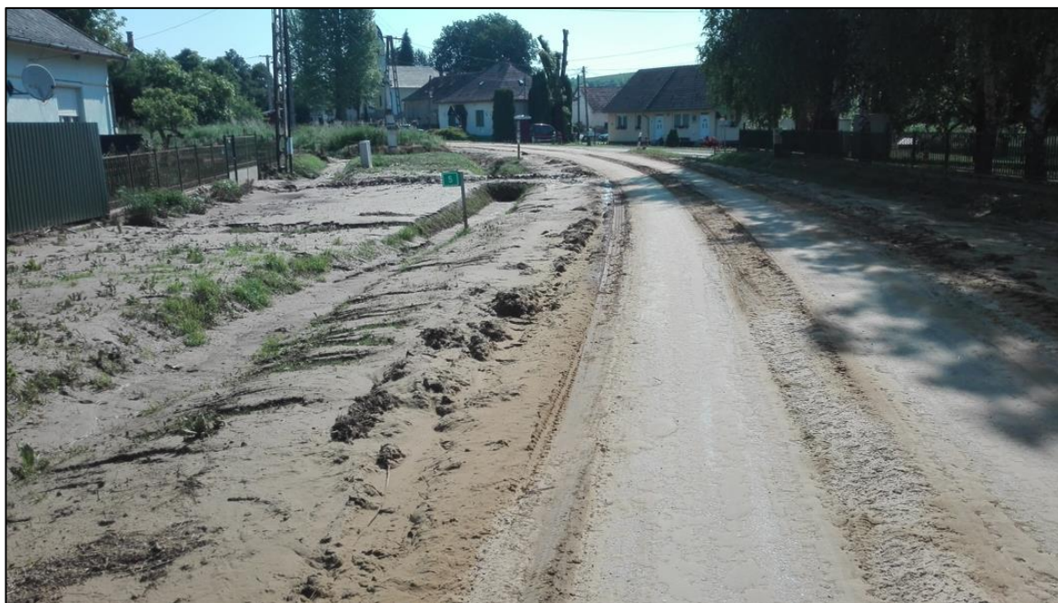
3. ábra. Oltárc település sárral betemetett csapadékvíz elvezető közúti árkai
