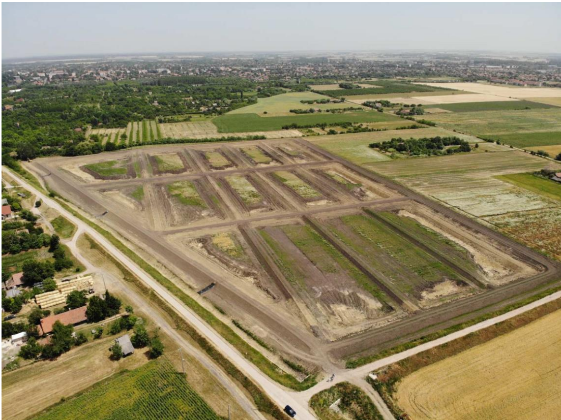
IV. zagykazetta és a Vízvisszavezető csatorna
