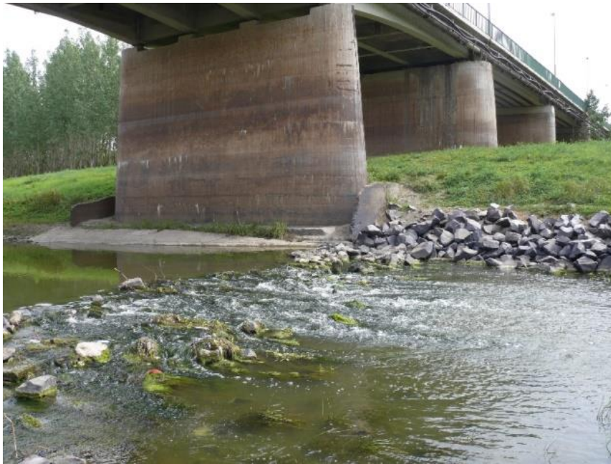
9. kép. Zagyva folyó 0+540 fkm-ben kiépült fenékgát
