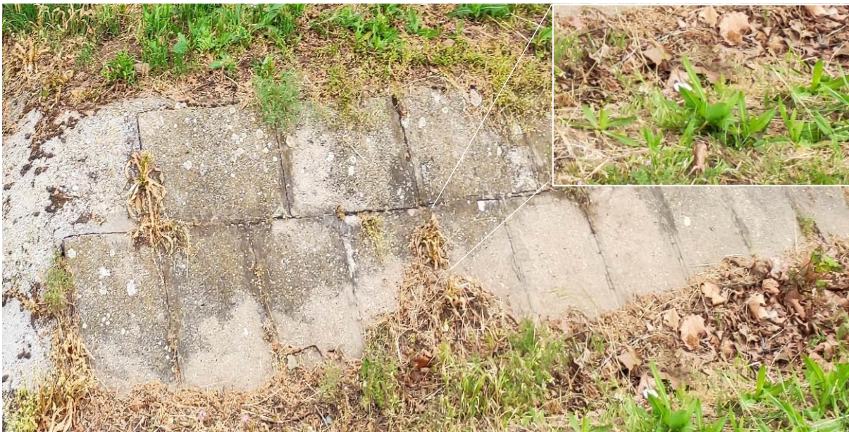
8. kép. Burkolt csatorna kezelt felülete
