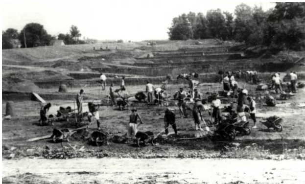
4. kép. A tivadari gátszakadás helyreállításán dolgozó kubikosok (1948) (Fotó: Konrád Rudolf)
