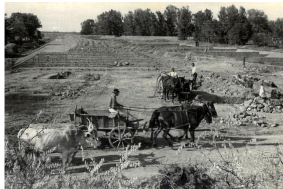
5. kép. Az 1947 szilveszteri gátszakadás után töltéskorrekcióval épülő új töltésszakasz építése fogatos munkával
