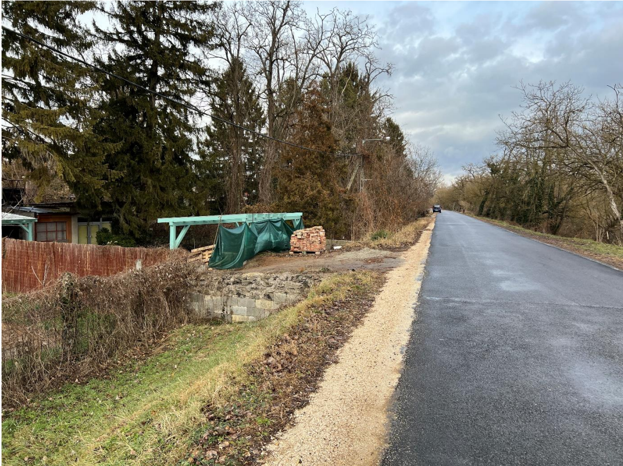
1. kép: 02.07.01 Surányi gátőrjárás - illegális rámpa
