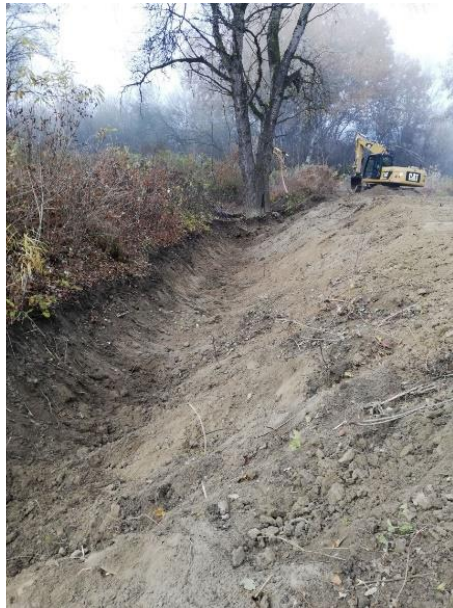
8. fénykép: Hullámtéri csatorna medertisztítása (Fotó: Dudás Péter)
