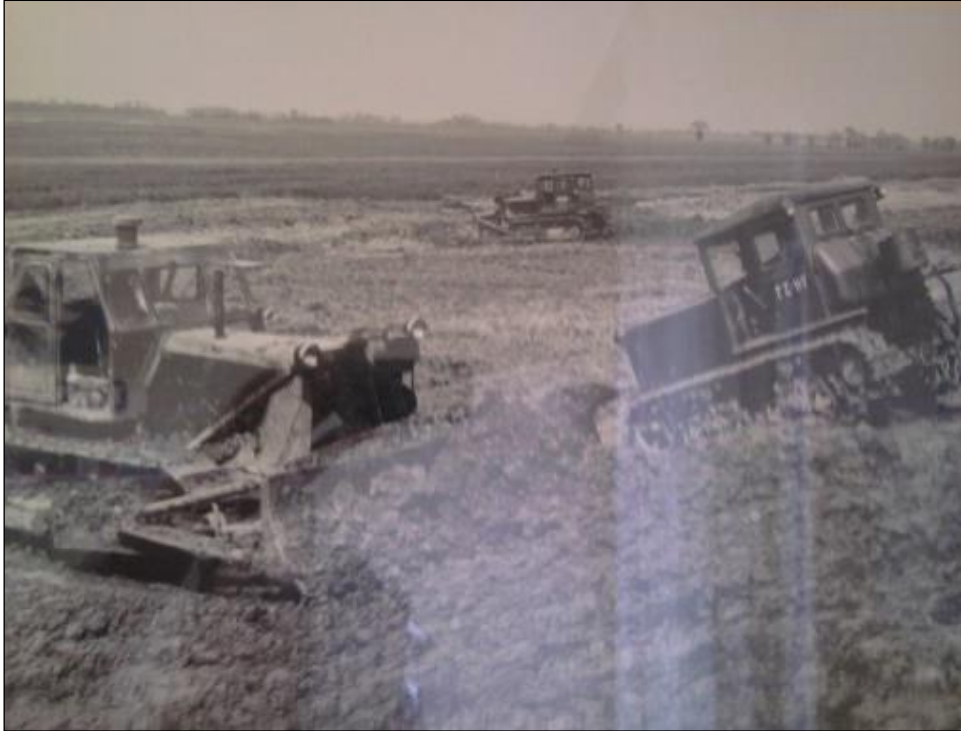
2. ábra. Tiszafüred - Tiszacsege között lokalizációs töltéserősítés (TIVIZIG, 1970 május)
