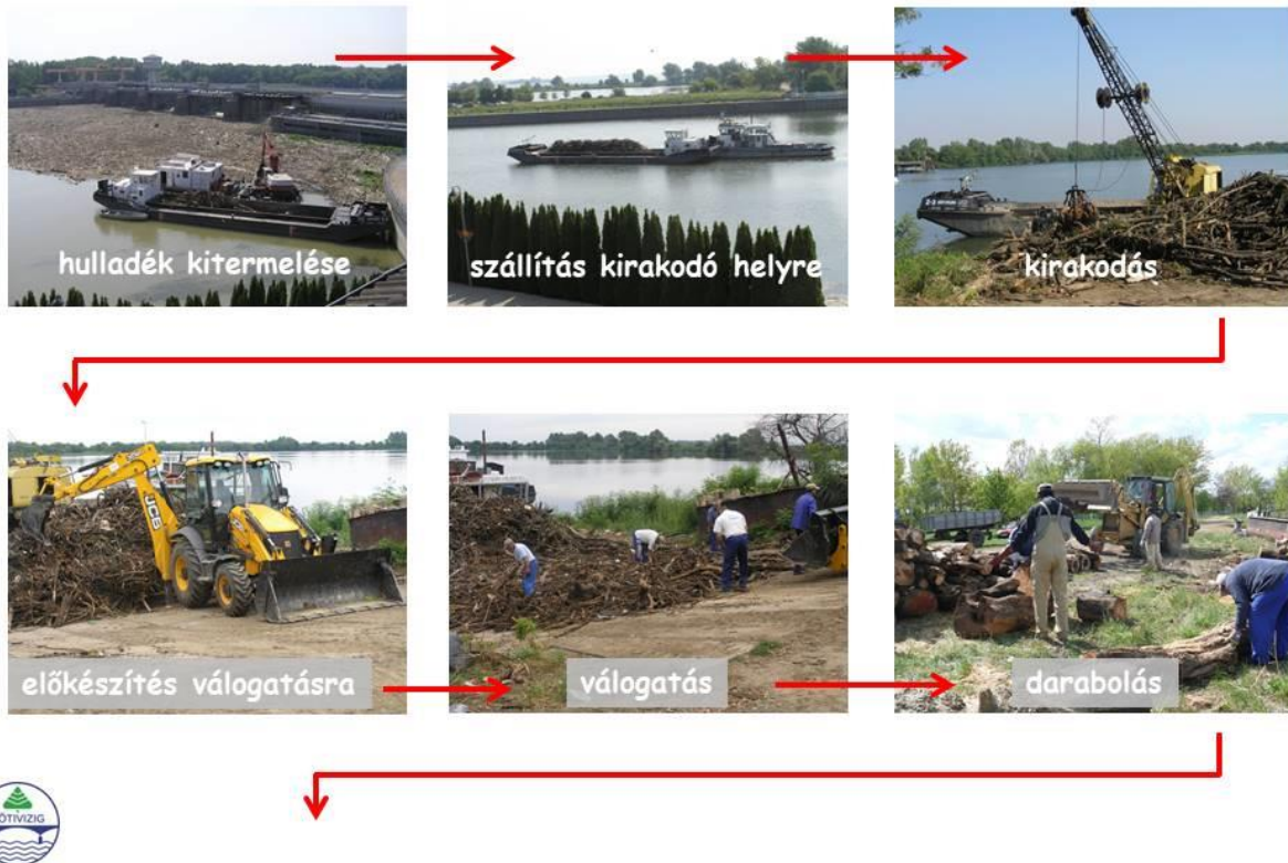
1. ábra: Uszadék eltávolítás munkafolyamata
