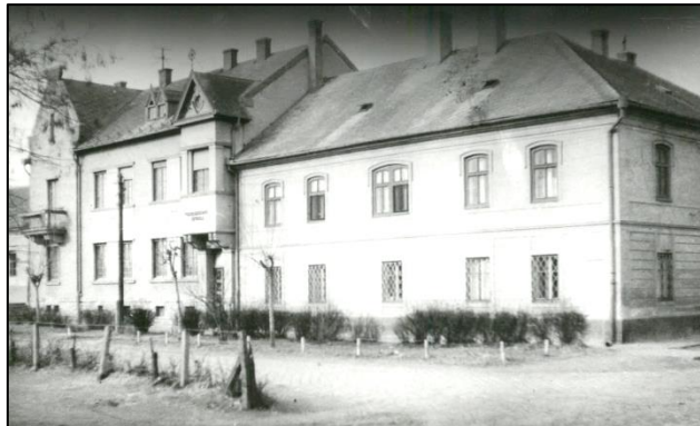
2. fénykép A Nyíregyházi M. Kir. Folyammérnöki Hivatal székháza a Búza tér 3. szám alatti épületben 1948-ig (Fotó: FTV Vízügyi Tört. Gyűjt.)
