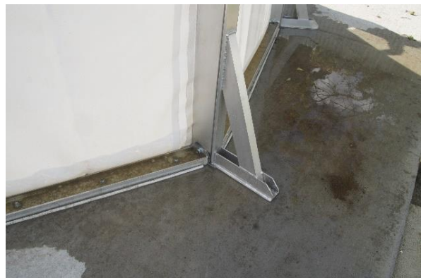
Vízzárósági próba nyolcszög alakú medence építésével
