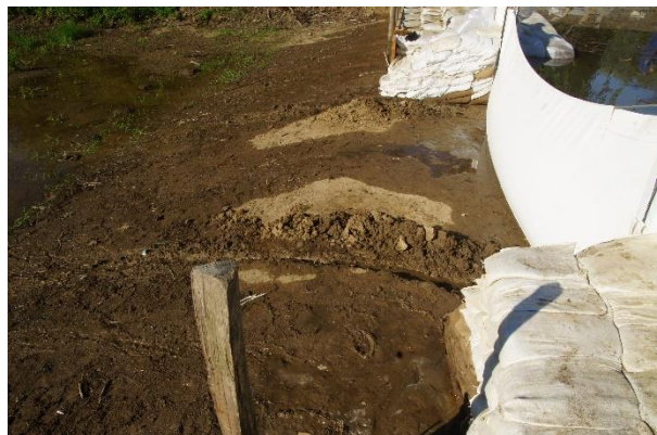
A 2018. szeptember 11-én végzett próba: példa a homokzsák-mobilfal kapcsolat kialakítására
