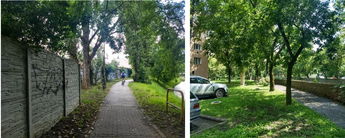
6. ábra. Elöntést befolyásoló vasbeton falak az Eger-patak mentén (Eger)
