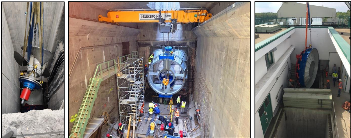
8.,9.,10. kép: Csatlakozó csőszakaszok telepítése 20 t daruval
