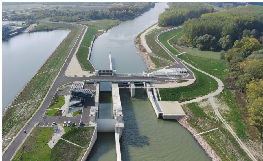
3. fénykép Mosonyi-Duna folyó rávezetése a torkolati műtárgyra
