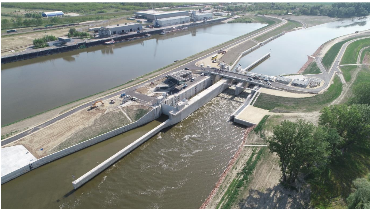
1. fénykép 2022.05.12-én készített drónfelvétel az alvíz felől
