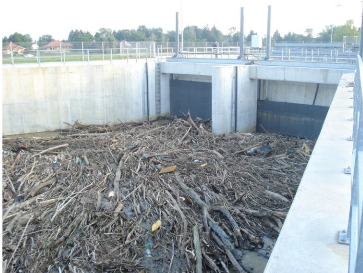
1. Fénykép. Az erőmű felvízi főelzárása előtt feltorlódott usadék
