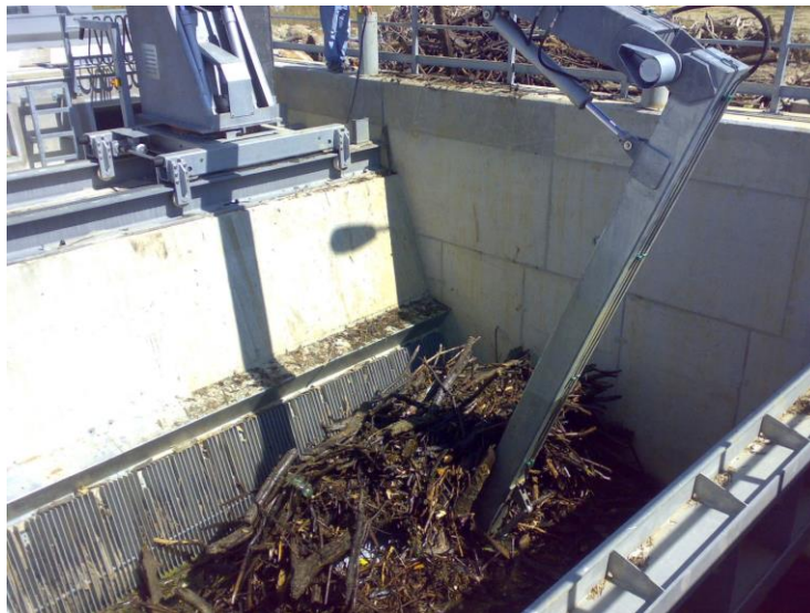
2. Fénykép. Az erőmű II. beömlő nyílása előtti gerebtsztító automatikus üzemben
