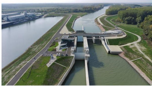
7. kép. Mosoni -Duna torkolati műtárgy (ÉDUVIZIG felvétel)
