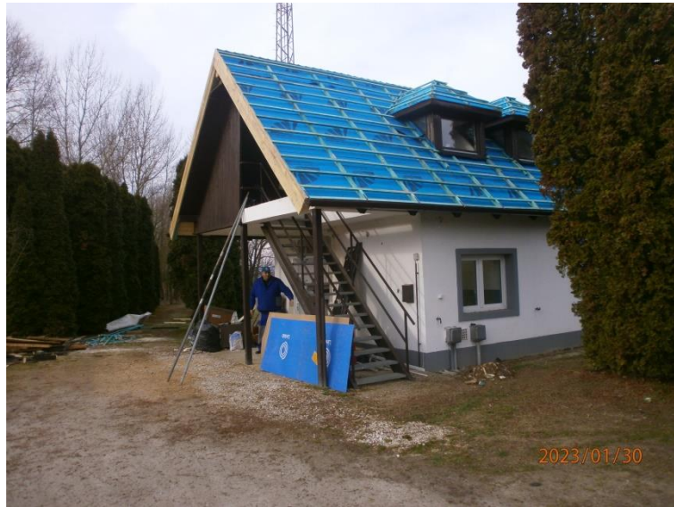
7. ábra - Tetőszerkezet felújítása
