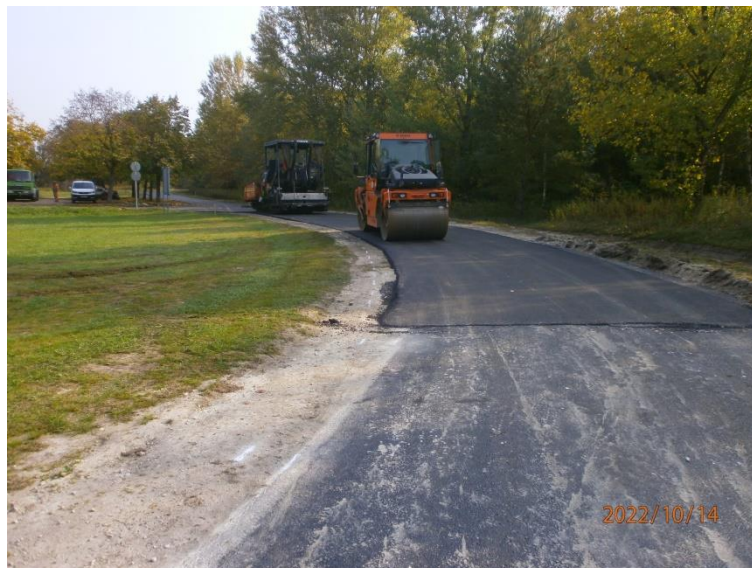
14. ábra – Bekötőút felújítás
