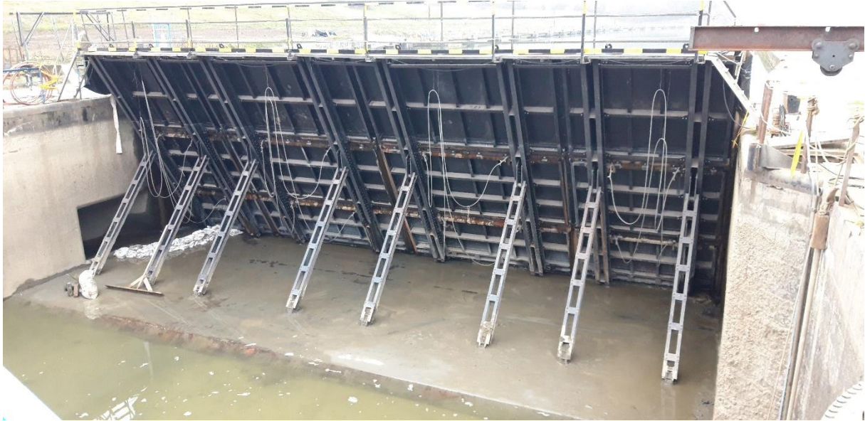
5. ábra Hajózsilip ideiglenes elzárószervezete
