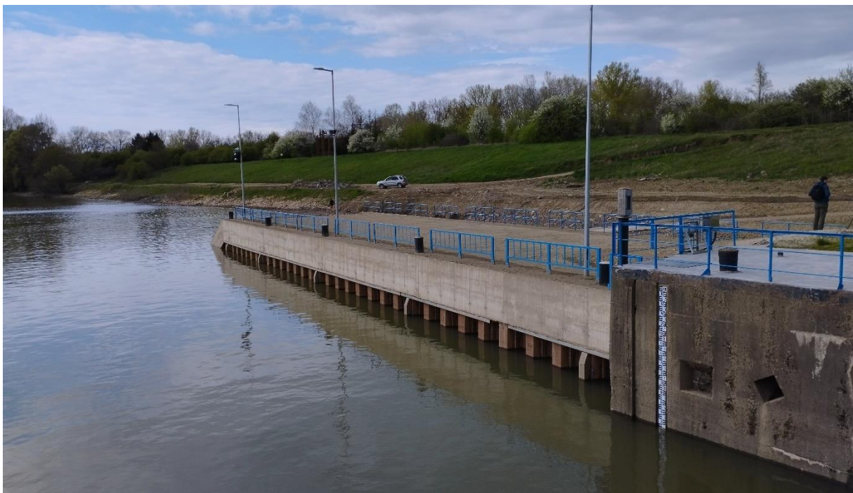
29. ábra Az új alvízi vezetómű
