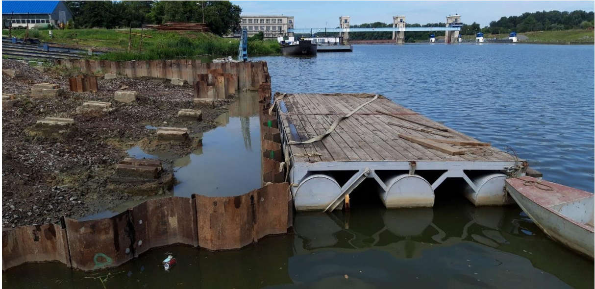
24. ábra Ideiglenes vízkizárás a sólytér felújítása során
