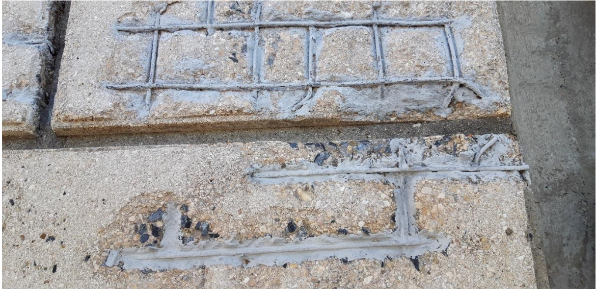
7. ábra Betonacélok passzíválása
