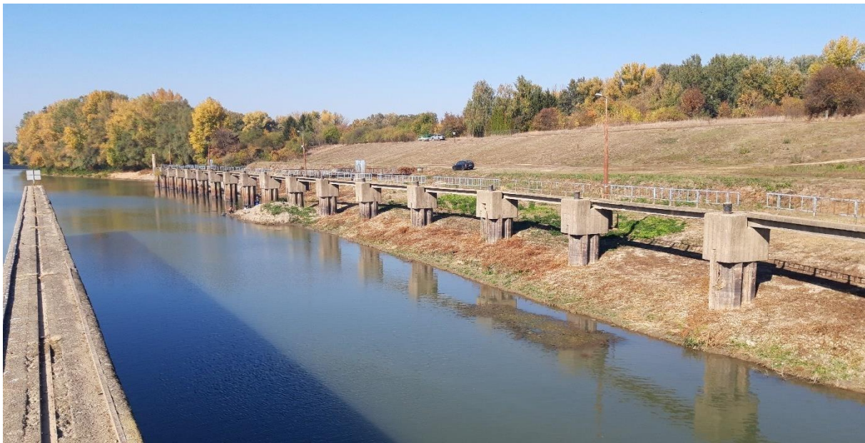
27. ábra Az elbontásra került alvízi vezetómű
