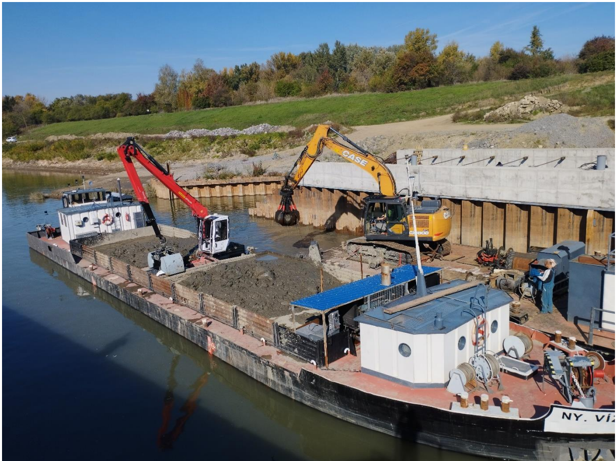
22. ábra Kotrás felső forgóvázis kotróval, úszóműről
