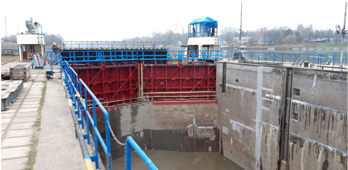
14. ábra Felújított dilatáció
