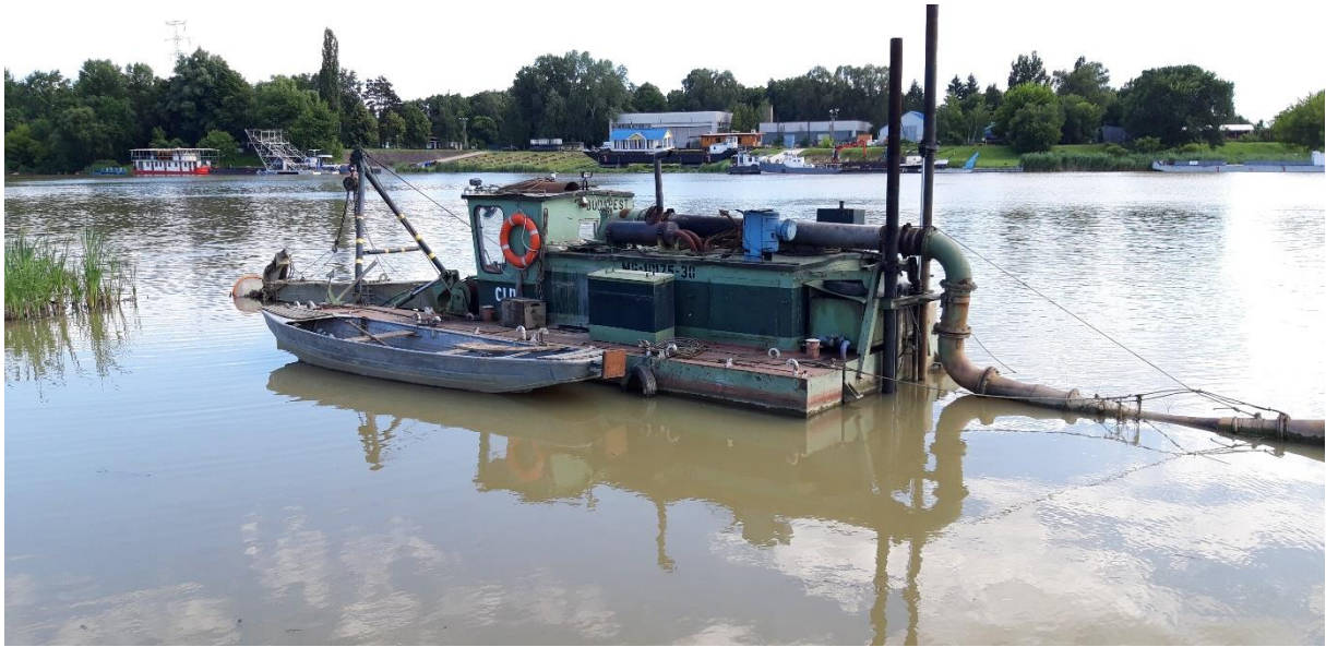
21. ábra Hidromechanizációs kotrás
