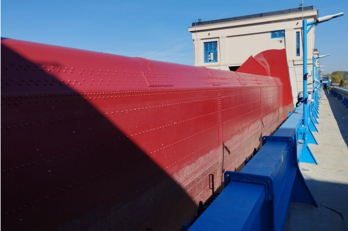
18. ábra Felújított főelzáró tábla
