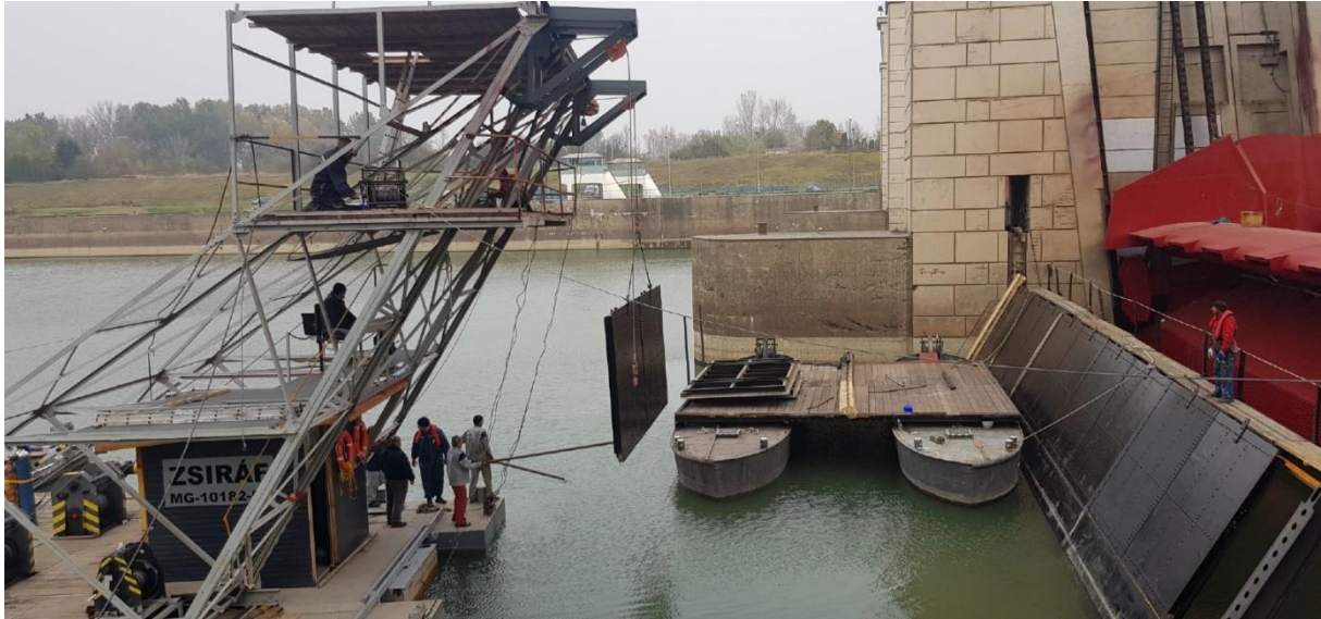
3. ábra Ideiglenes elzárás építése
