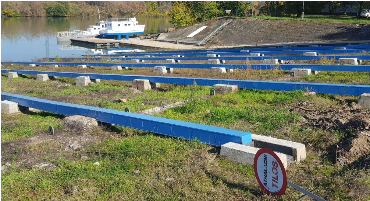
25. ábra Sólytér a felújítás után
