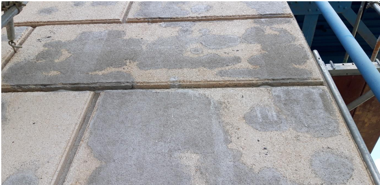
8. ábra Pillér betonburkolatának javított felülete
