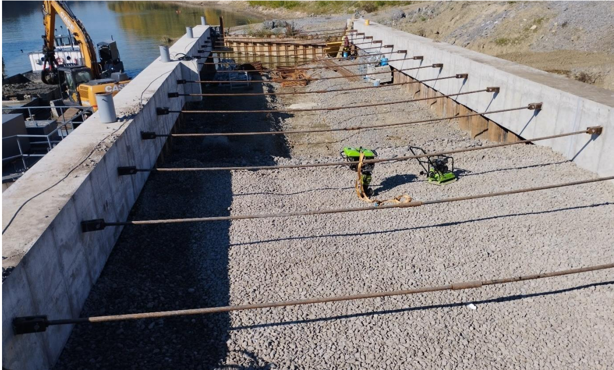
28. ábra Az alvízi vezetómű építése
