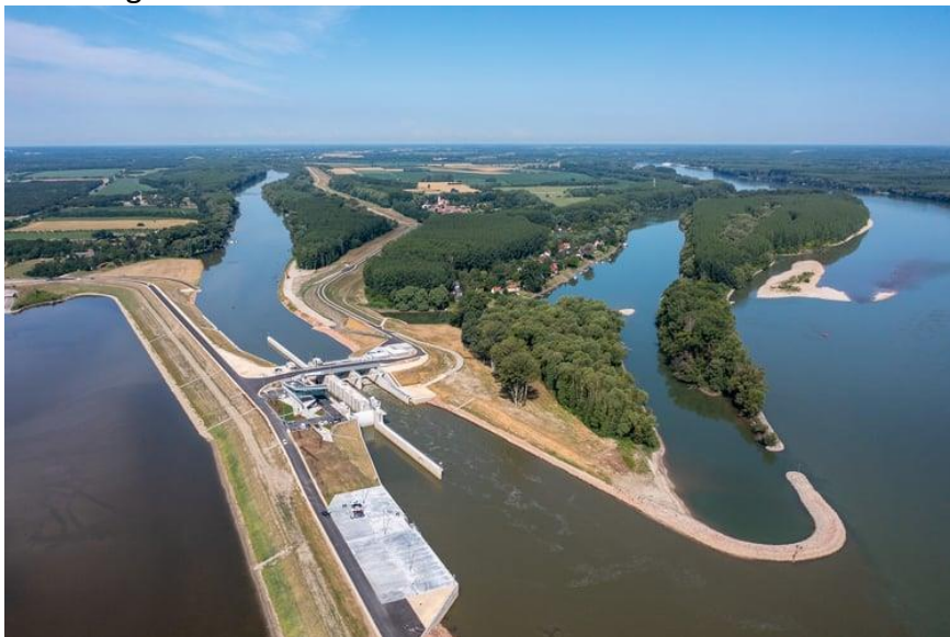
35. Ábra. A Mosoni Duna torkolati műtárgy
