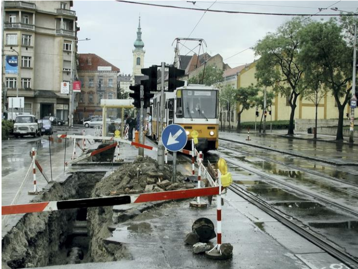
26. ábra. Gyakorlatilag védelem nélküli GÖV cső fektetése
