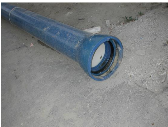
17. ábra. Gurul a cső a betonon
