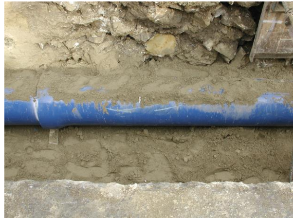
40. ábra. Sérült bevonatú cső betakarása
