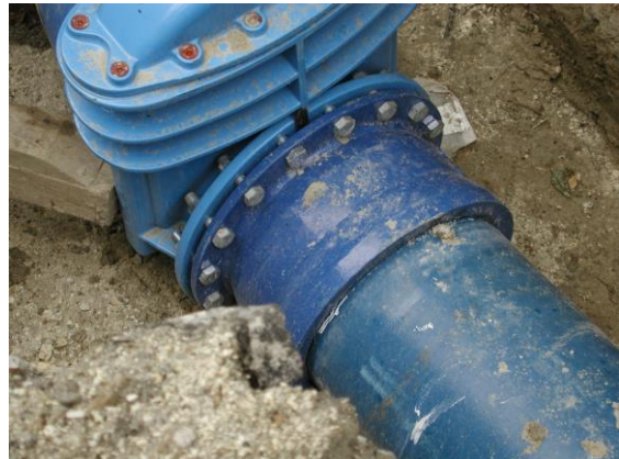
37. ábra. Itt még több csavar, hol a védelem?
