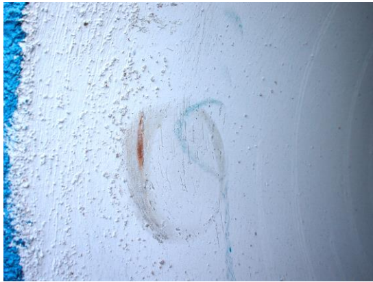
7. ábra. Megindult korrózió.
