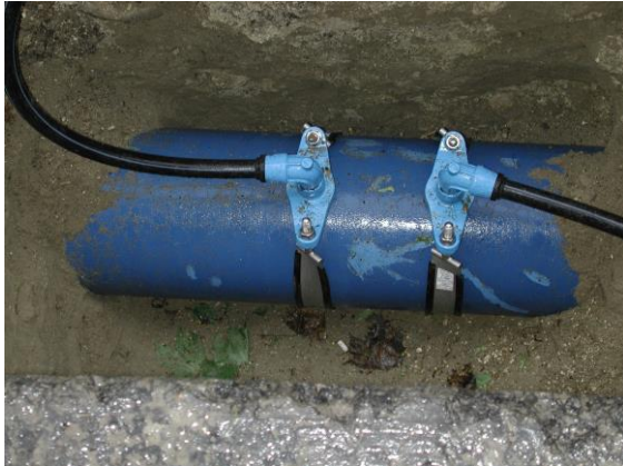
36. ábra. Itt a csavar, hol a védelem?
