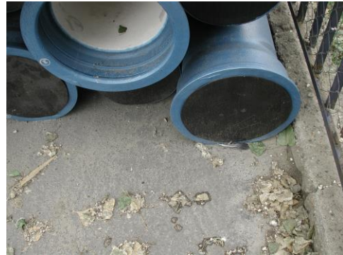
19. ábra. A tok a járdába nyomva
