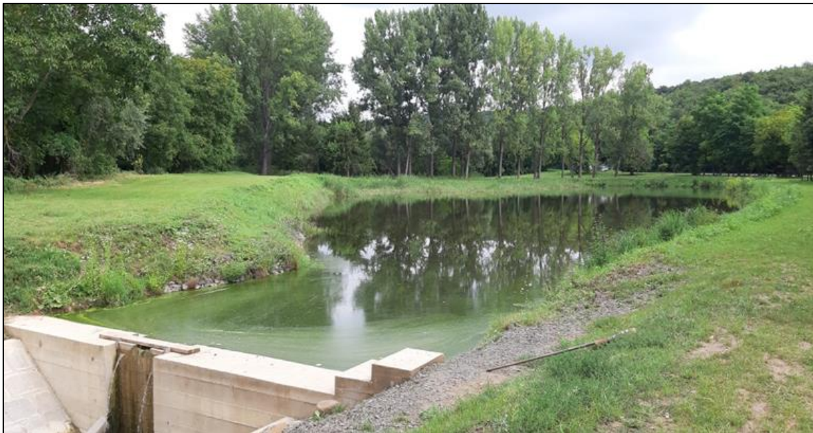
3. fénykép – Szilágyi-patakon kialakított oldaltározó
