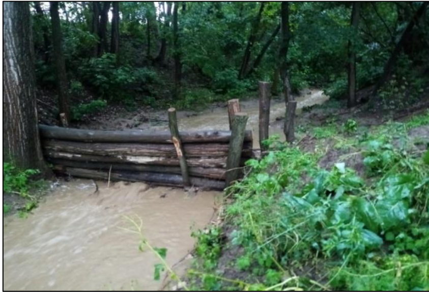
4. fénykép – rönggát a Szilágyi-patak mellékágán
