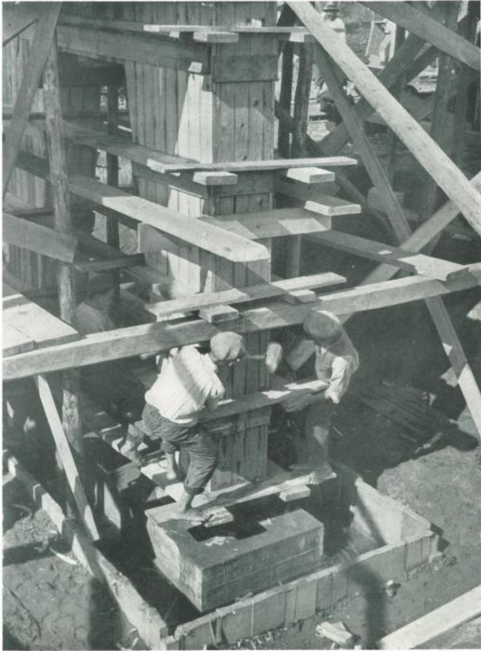
4. kép: Pillérzsálat készítése (Forrás: 1938. évi Vízügyi Közlemények 4. számának különnyomata)
