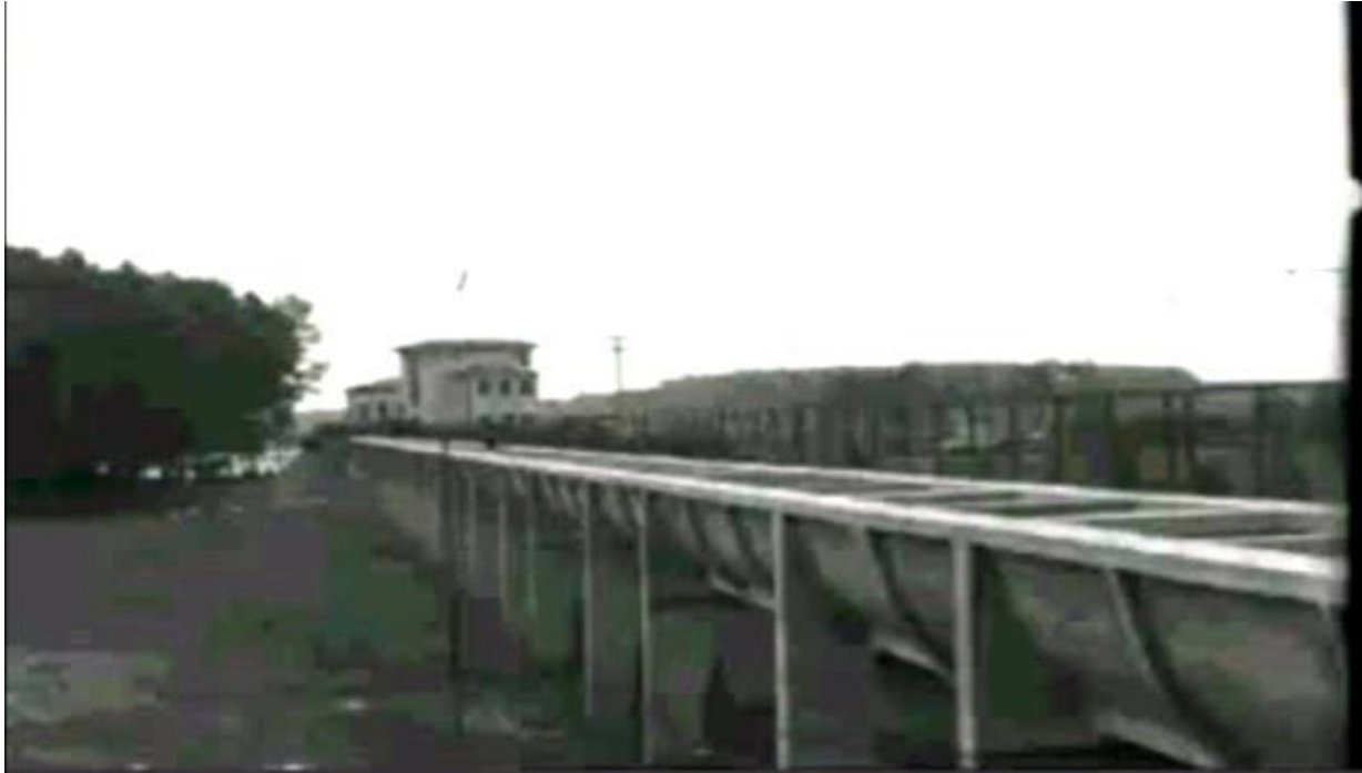
11. kép: A csatornahíd háttérben a szivattyúteleppel (Forrás: Magyar Világhíradó 853. adása)
