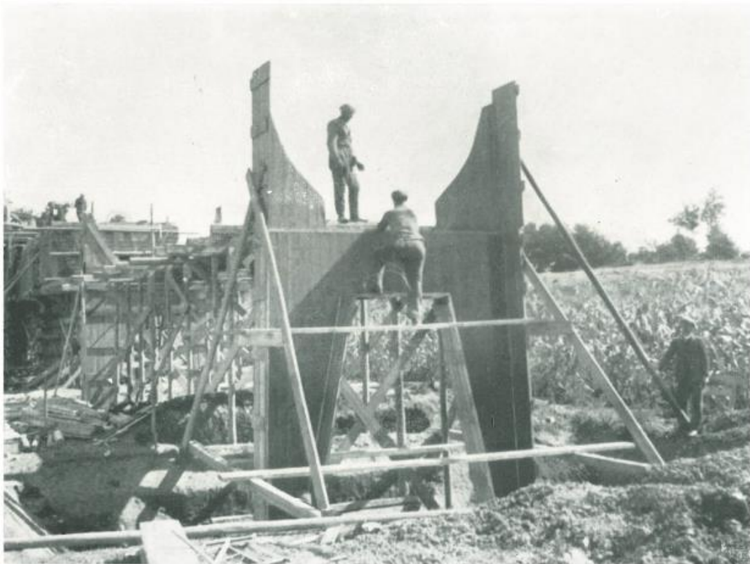
3. kép: Pillér zsaluzatának készítése (Forrás: 1938. évi Vízügyi Közlemények 4. számának különlenyomata)
