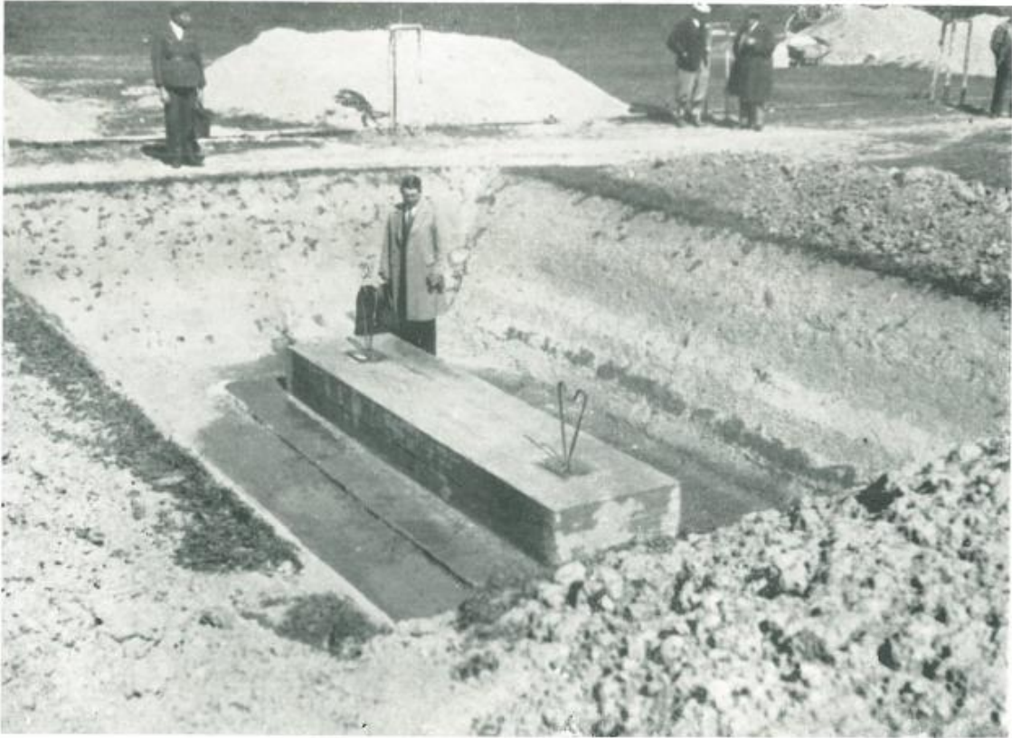
2. kép: Az elkészült pilléralap a pillér két talpcsuklójával (Forrás: 1938. évi Vízügyi Közlemények 4. számának különlenyomata)
