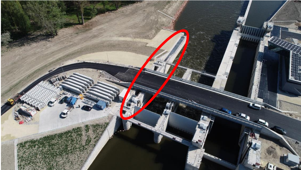
3. kép: Réselt halátjáró a Mosoni-Duna torkolati műtárgynál Fotó: ÉDUVIZIG
