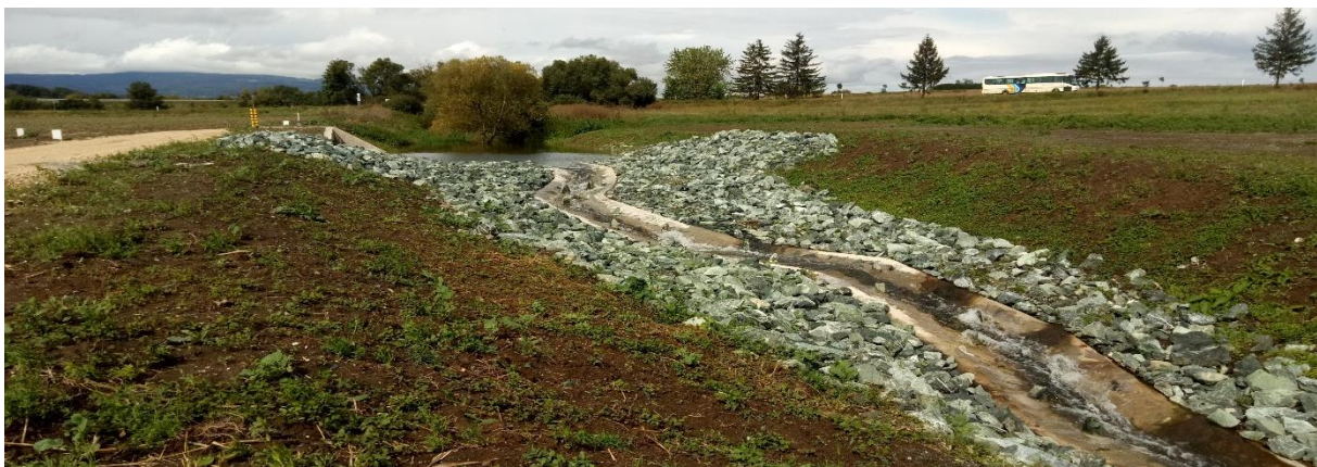
1. fénykép: Átjárható fenékküszöb Arany-patak, Dozmat Fotó: SOLVEX
