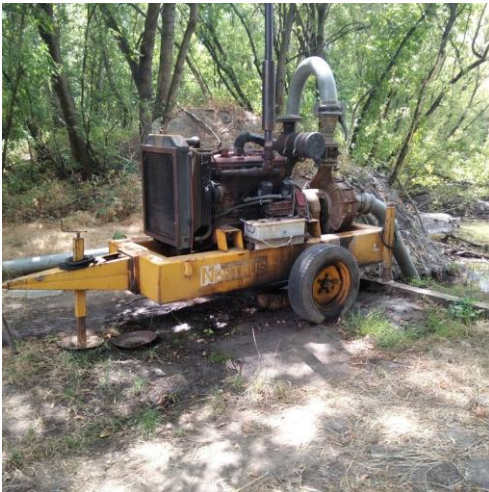
Zagyva 76+600 (Zagyvamenti 2001 Zrt.)
