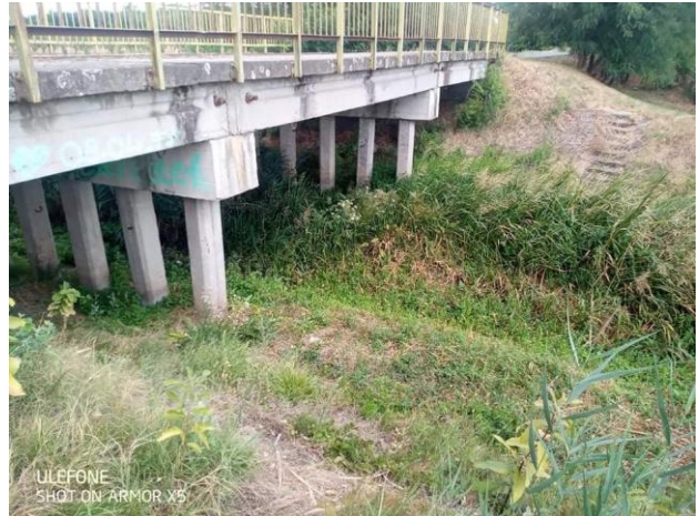
Tápióbicske közúti híd
