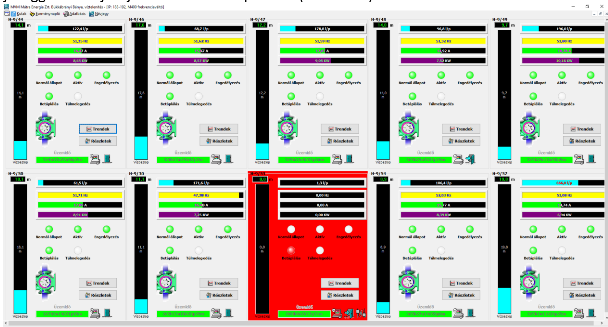
4. ábra Frekvenciaváltóval szerelt kútszekrények főbb üzemi adatai (kút neve, vízszint, hozam, Hz, A, KW, üzemállapot, halmazott üzemóra, trendek-, részletek kapcsolója)
