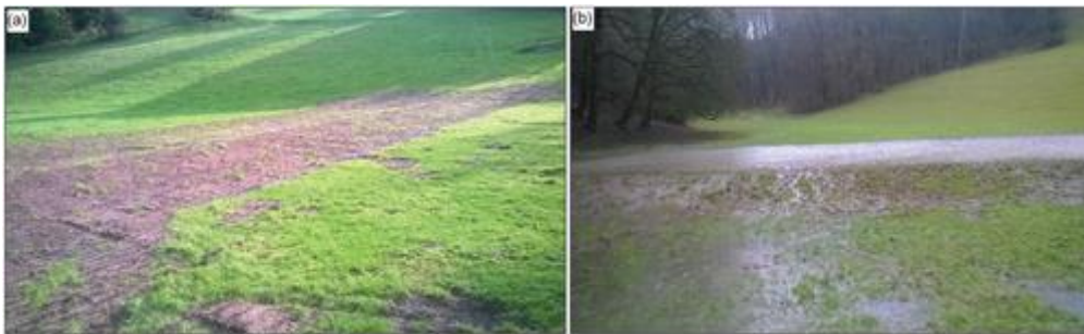
4. ábra: Vízvisszatartó földsáncok a Frome vízgyűjtőjén, Anglia (forrás: https://onlinelibrary.wiley.com/doi/full/10.1002/ldr.3205?saml_referrer )
