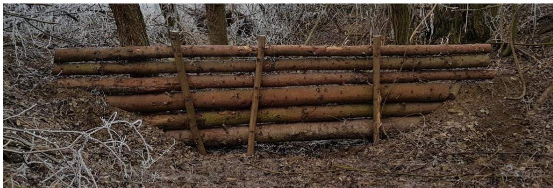
8. ábra: Rönkgát Püspökszilágyi határában
