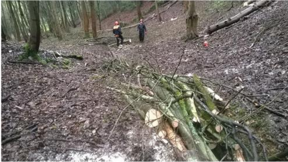
3. ábra: Felszíni lefolyás-lassító rőzsekötegek a Frome vízgyűjtőjén, Anglia (forrás: https://onlinelibrary.wiley.com/doi/full/10.1002/ldr.3205?saml_referrer )
