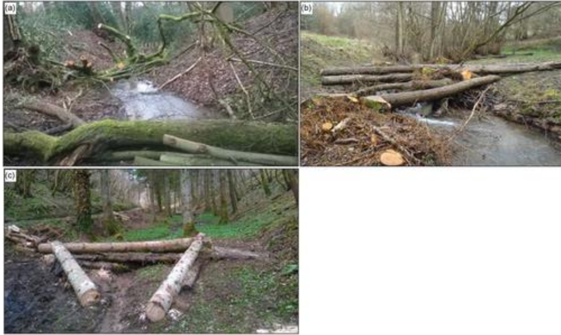
2. ábra: Rönkgátak a Frome vízgyűjtőjén, Anglia
