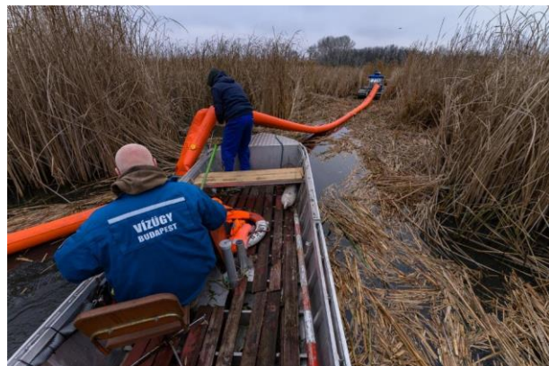
3. ábra VIKOMA merülőfal kihelyezése
