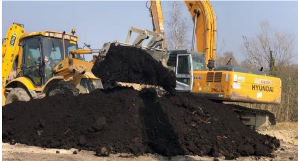
5. ábra A parti sáv és az övzátonyok terítése zalai tőzeggel
