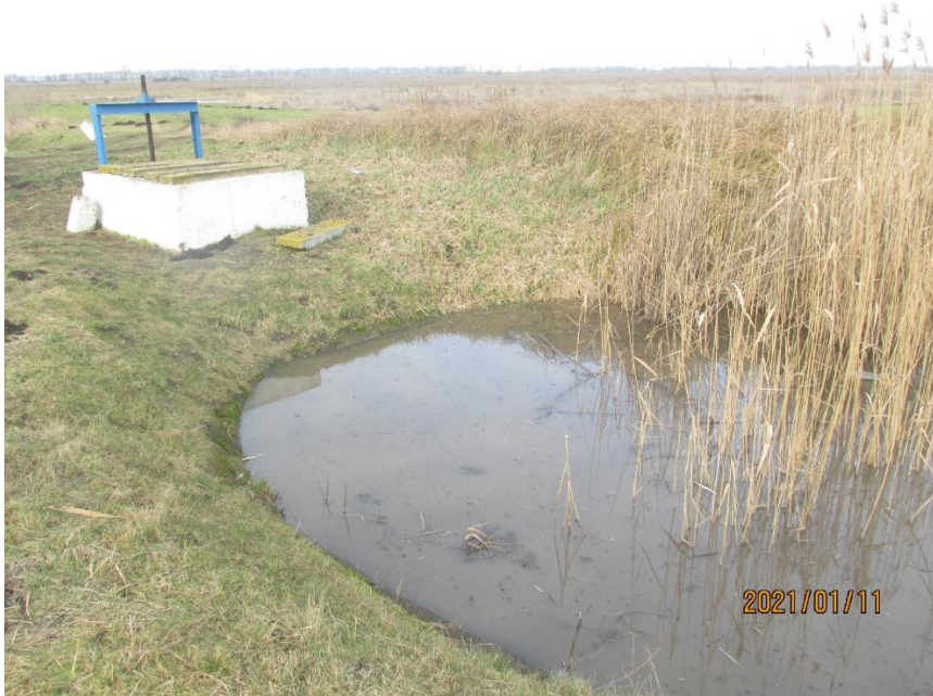
3. ábra A vízkormányzás eredménye a terület legdélebbi műtárgyánál (fényképek: Hoffmann Károly)
