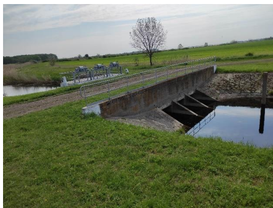
5. ábra Sárréti-főcsatorna 11+076 km szelvényében lévő tiltós műtárgy (Készítette: Verik Zsolt, csatornaőr, 2023.05.04.)
