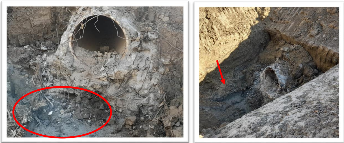
13. sz. képsorozat: Vízoldali nyomócső bontás, „ágyazati” kialakítás
