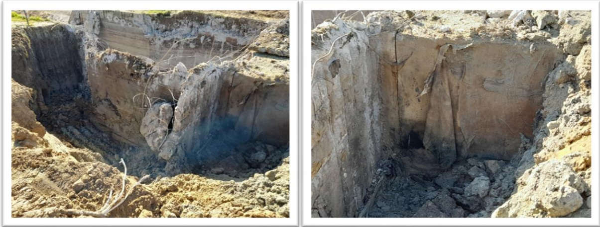
16. sz. képsorozat: Keretelemes zárt csatornaszakasz bontása, terfil borítás
