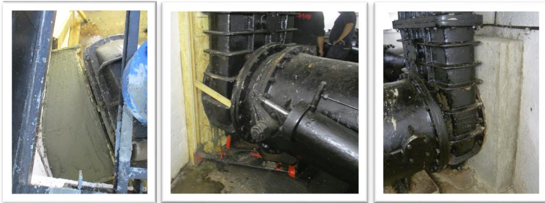
8. sz. képsorozat: Körtvélyesi szivattyútelep – 2019. évi nyomócső meghibásodás javítása
