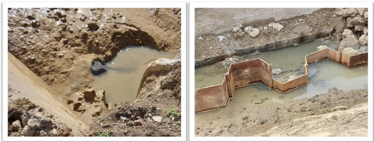
17. sz. képsorozat: Munkagödörbe történő vízbeáramlás és „homokolás”
