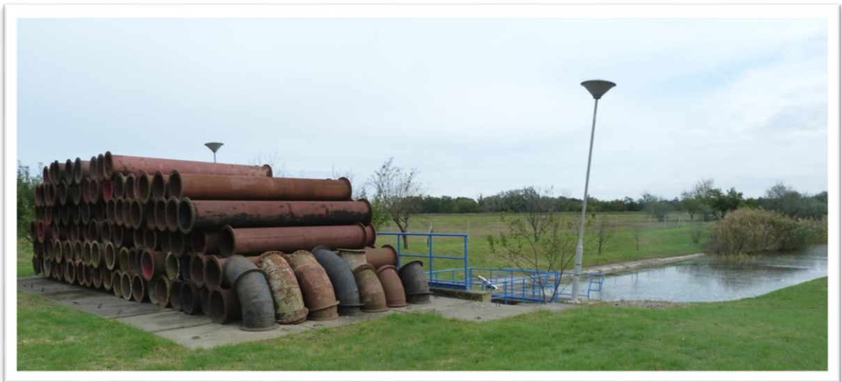
6. sz. kép: Körtvélyesi szivattyútelep – Provizóriumhoz szükséges anyagkészlet
