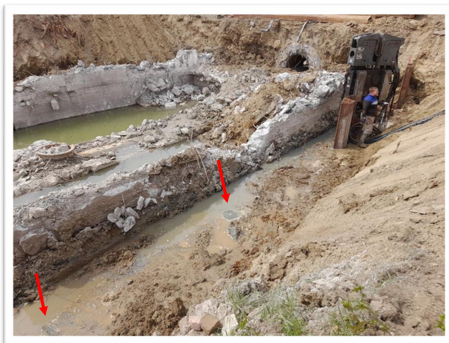
18. sz. kép: Munkagödörbe történő vízbeáramlás és „homokolás”
