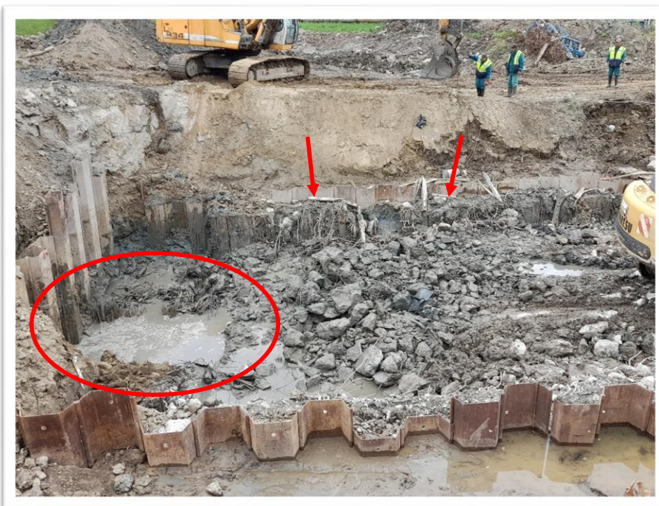
15. sz. kép: Gépház alépítmény bontás, fa cölöpsoros alapozás és bennmaradt zsaluzat
